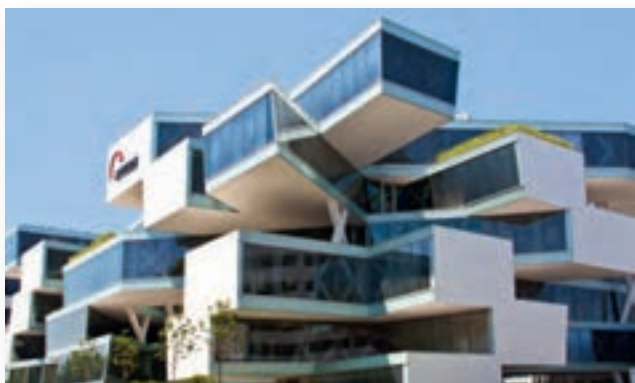
Besonderes Fachwissen ist bei der Schätzung des Versicherungswerts gefragt: Neues Gebäude der Firma Actelion in Allschwil.
